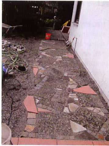
Alte Platten neu verlegt
